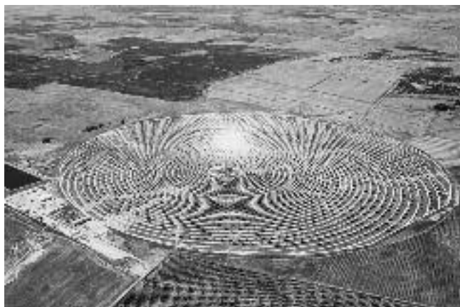
Первая в мире солнечная электростанция «Gemasolar» мощностью 19,9 МВт построена в испанской Андалусии. Электростанция оснащена двумя баками расплавленных солей, которые собирают тепловую энергию, производимую в течение дня. Таким образом она может генерировать электроэнергию 24 часа в сутки.
